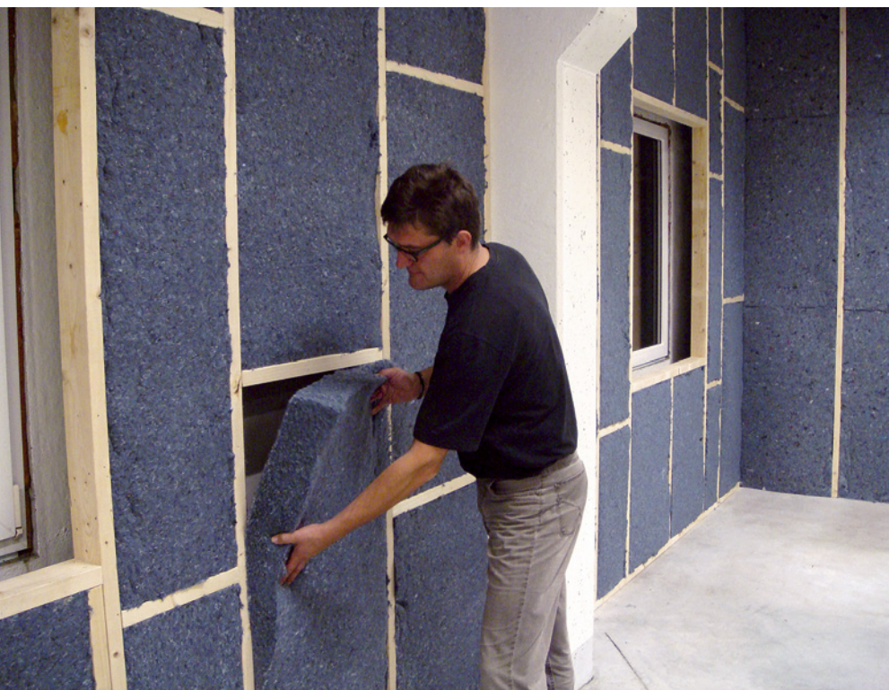
Plaatsing van textielisolatieplaten tussen een houten rooster.
