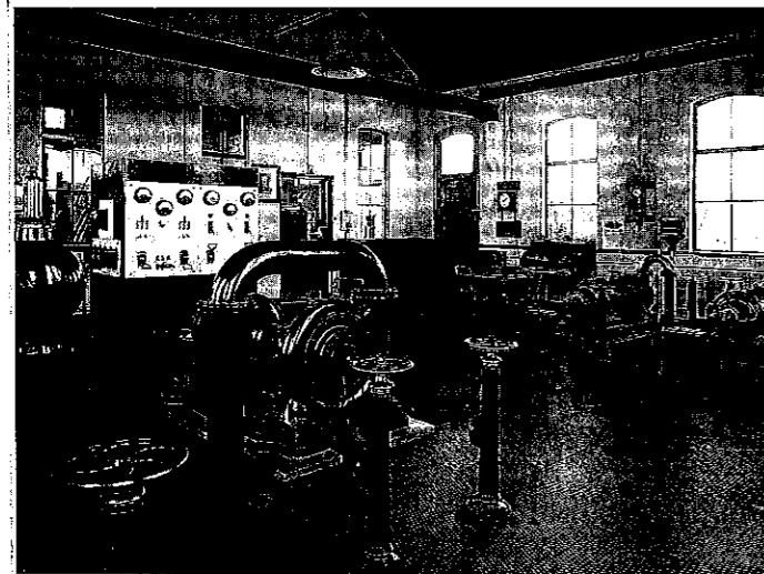
Vol-elektrisch pompstation met schakelkast Bussum-Weesp
